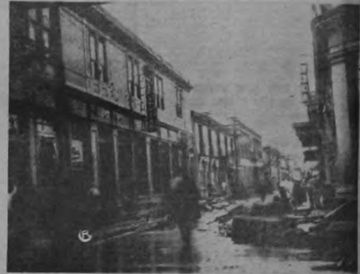
Un aspecto de la Avenida Central cuando estaba en proceso de pavimentación. La foto fue tomada en la esquina donde estaba el Diario de Costa Rica.
