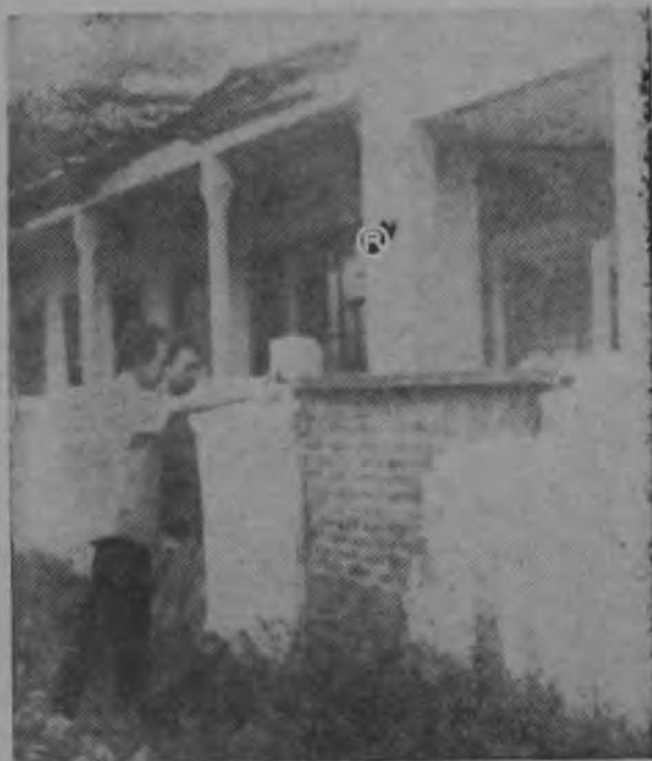
Frente al Malecón existía este boquete en la pared, que se estaba usando como puerta para las reparaciones del edificio del Hospital. El portón provisional que existía, cerrado por una argolla de alambre y un candado, apareció violentado, la madrugada que se fugó Leonel Cabezas.
